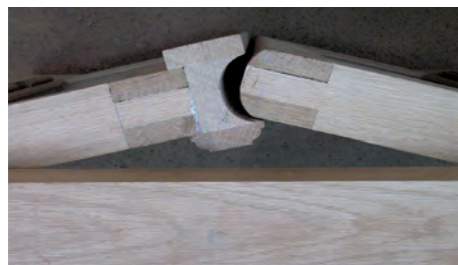
Detail : openslaande vleugel met hol-en-dolle lijst. Foto: J. Bertrand - Stadswinkel
